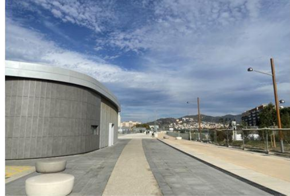
Figura 7. Nueva plataforma peatonal sobre las vías.
