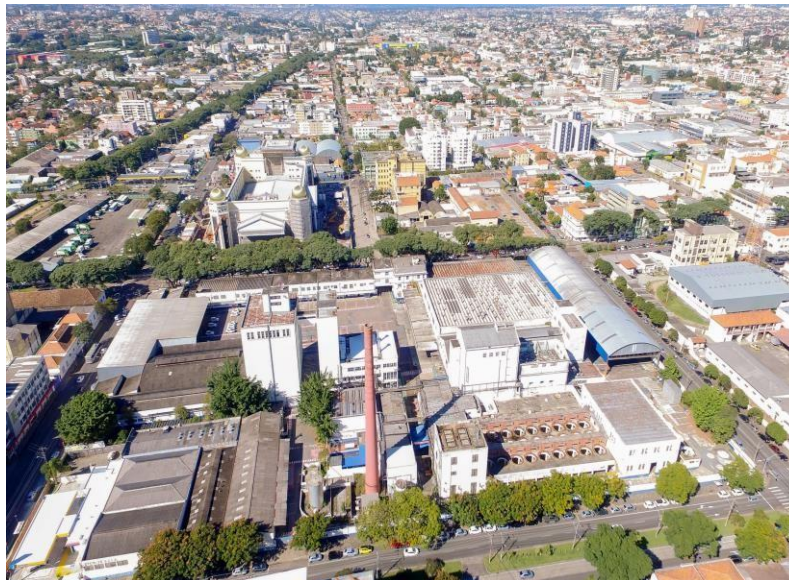
Figura 1: Vista aérea do Vale do Pinhão (Fonte: Ippuc/PMC)
