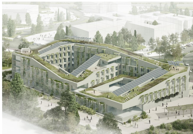
Edificio in CLT più grande della Spagna (campus universitario a Madrid)
